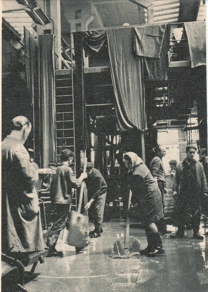
La secția imprimerie a fabricii textile «Tirnavă» din Mediaș se recondiționează țesăturile deteriorate.
