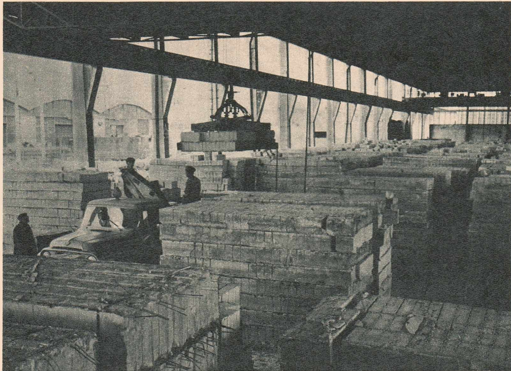
Întreaga muncă subordonată comandamentelor reconstrucției! De curînd, colectivul fabricii de prefabricate Militari și-a suplimentat planul de betoane celulare autoclavizate cu încă 7 000 mc. Din acestea 2 000 mc vor fi livrate în mod gratuit zonelor afectate de inundații.
