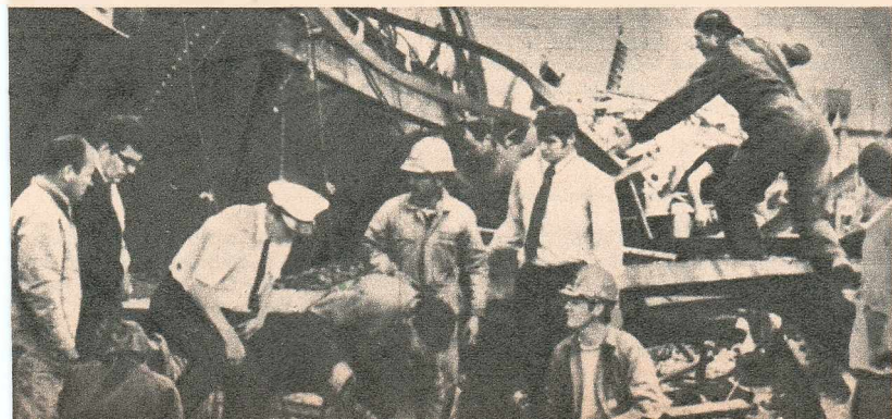
«După prabușirea podului West Gate din Melbourne, Australia. Agențiile de presă menționează că era vorba de cel mai lung pod al continentului și că în acest accident și-au pierdut viața 28 de persoane.»
