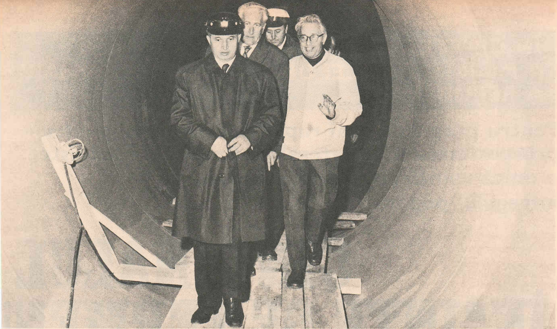
▲ Străbătind galeriile subterane ale hidrocentralei de pe Lotru.
