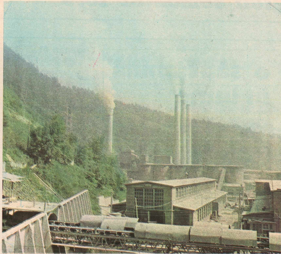
▲ Vedere generală a secției de ciment.
