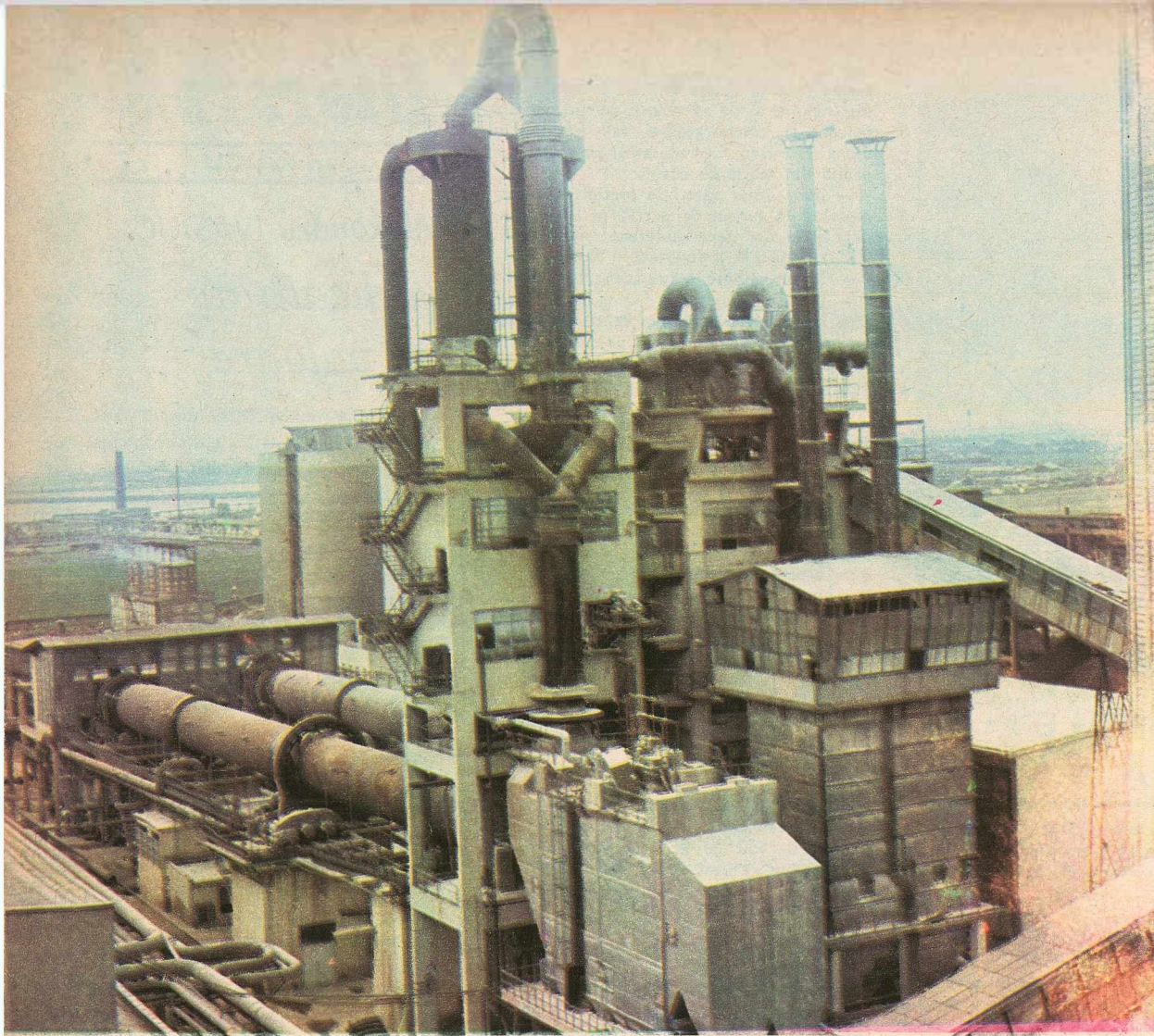
▲ Vedere generală a instalației de calcinare a aluminei.
