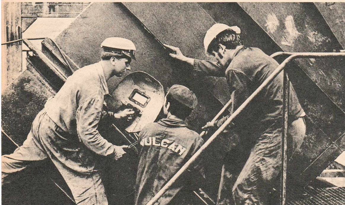
Și pe șantierul Combinatului chimic din Arad, centrala termoelectrică este un lucru foarte important. Pentru prezent, dar, mai ales, pentru viitor. Atestarea poate să vină și de la firma «Vulcan» de pe spatelii montorilor. (E. Ghera)
