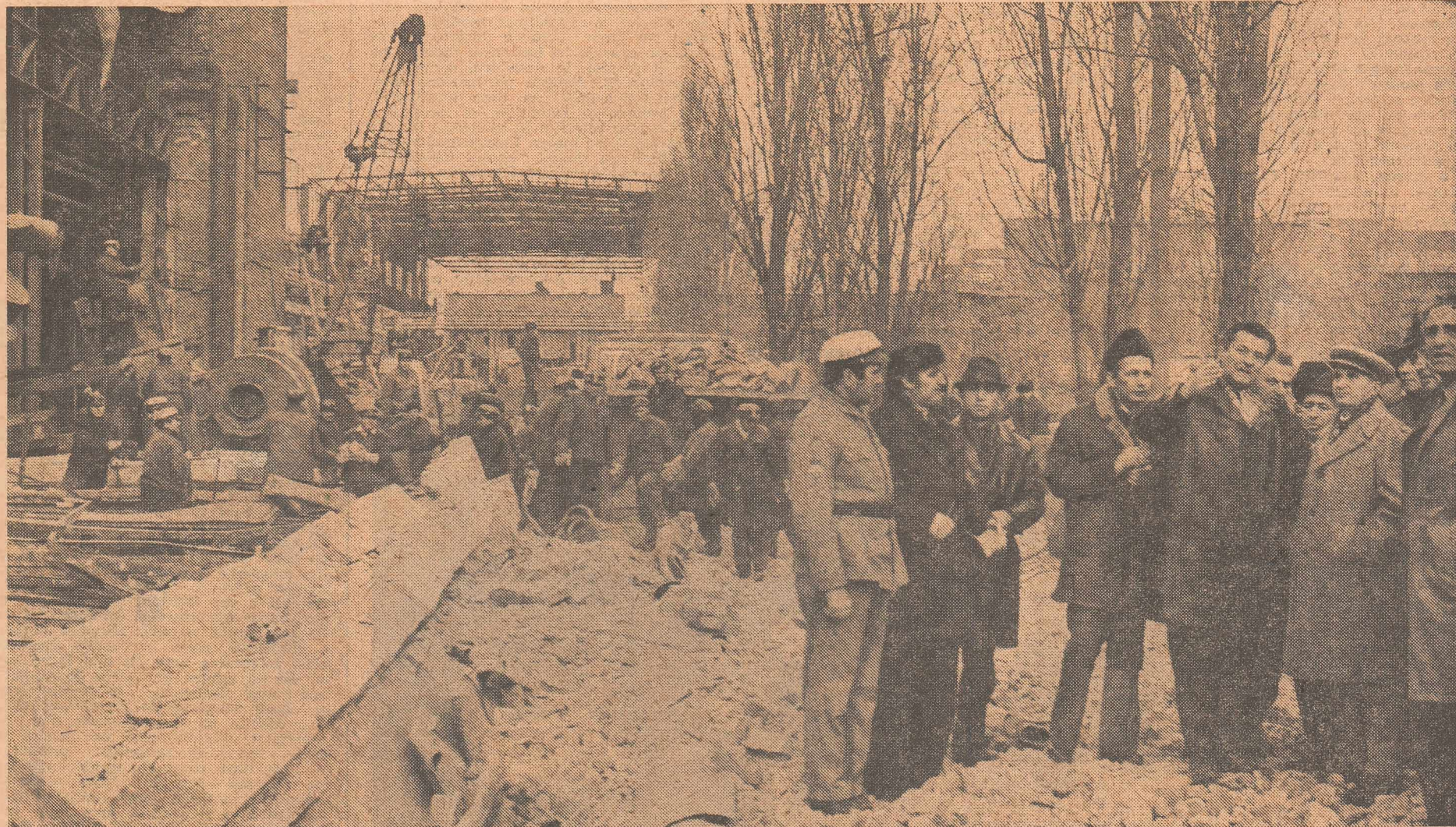
Din nou în unități bucureștene unde se desfășoară lupta încordată pentru lichidarea urmărilor seismului
