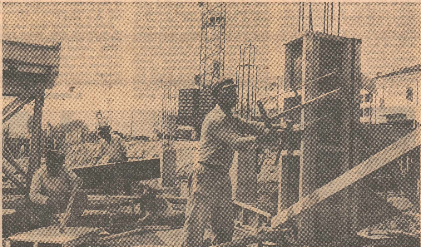
Reconstrucția la zi în Roșiori de Vede
