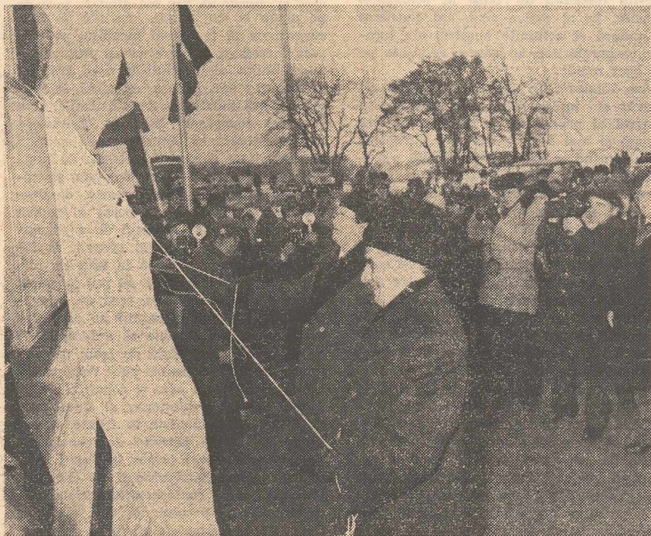
Se dezvelește una din cele două plăci inaugurale ce marchează deschiderea șantierului hidrocentralei Porțile de Fier II.
