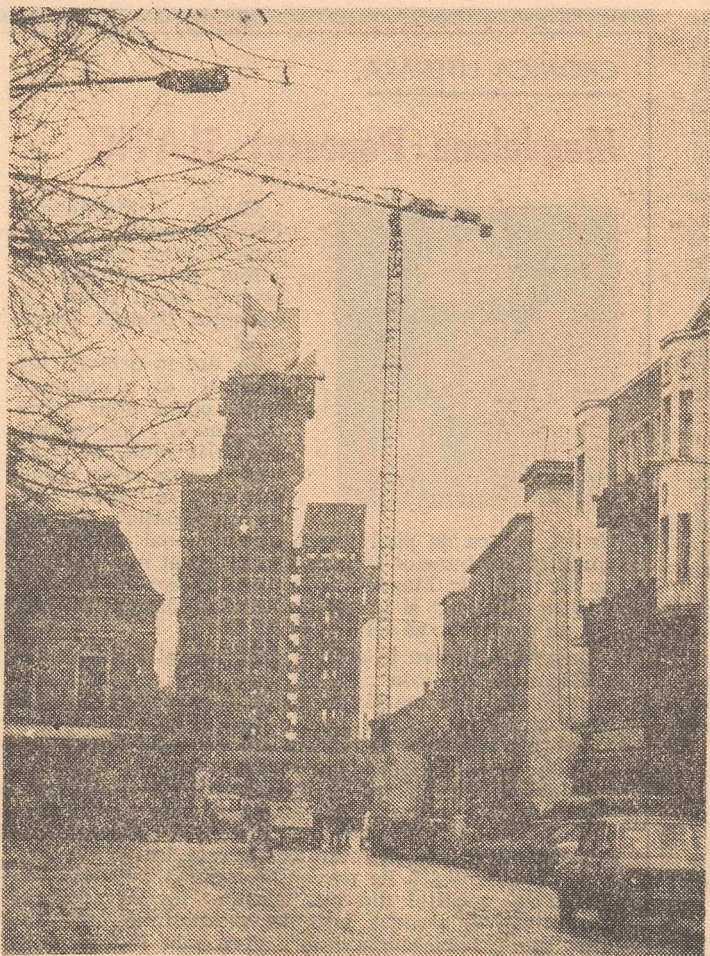
La Satu Mare, pe malul Soarelui, se află în fază înaintată de construcție una dintre cele mai înalte clădiri din țară.
