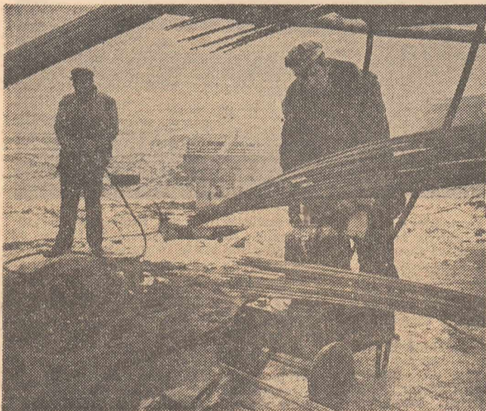
Tensionarea cablurilor continuă. Deși orele de program s-au încheiat de mult, munca mai are încă nevoie de podari
