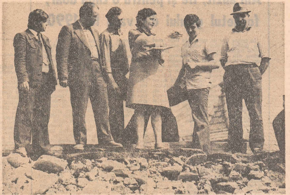
În fața unui pod rupt de ape (apele năvalnice ale munților mai rup și poduri), primărița Elena Anton, sosită prompt, împreună cu alți factori de răspundere ai comunei, decide măsurile reconstrucției
