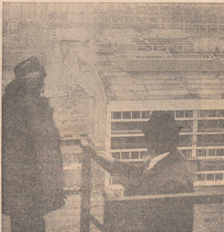
Dincolo de sticla și betonul care o alcătuiesc, uzina de produse clorosodice din Giurgiu înseamnă muncă, seriozitate, abnegație, pricepere.
