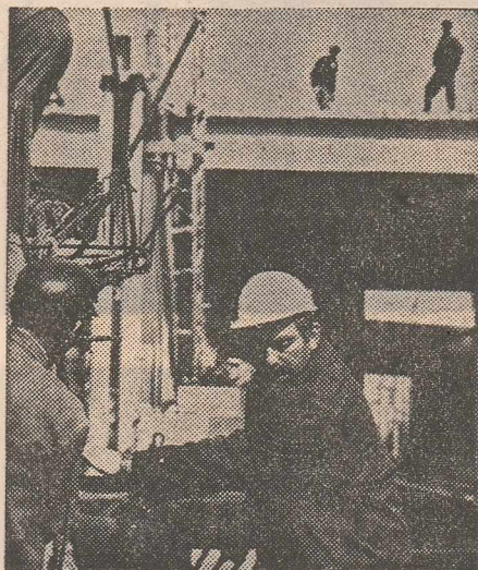
Omul din centrul fotografiei este maestrul principal Gheorghe Zamfir. A condus operațiunile de montat grinzi de la prima și pînă la ultima și nu s-a mulțumit cu atât, a pus mina acolo unde era nevoie.
