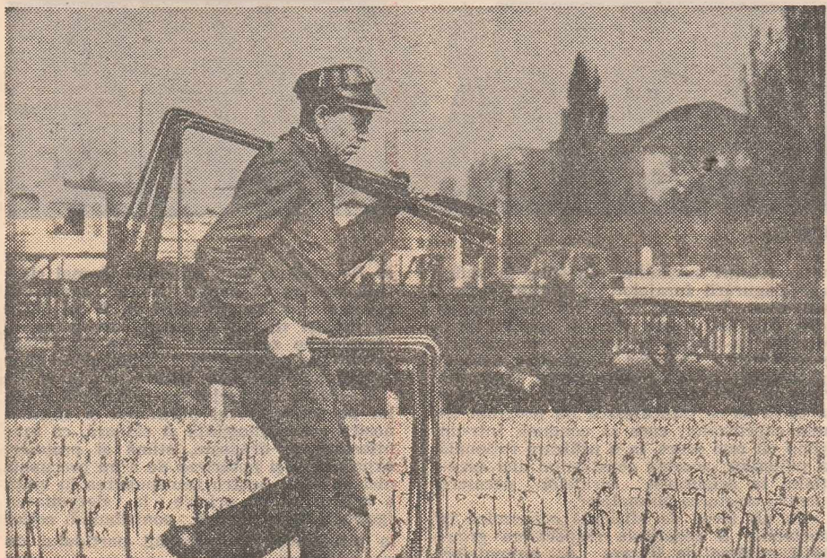
Toate grinzile fiind puse, de-acum se poate trece, la pas, de la un capăt la altul, întreg pasajul, ceea ce betonistul Costică Nicorici și face. În rest, e treaba lor a betonistilor, sudorilor și dulgherilor, de a definiva și finisa construcția.
