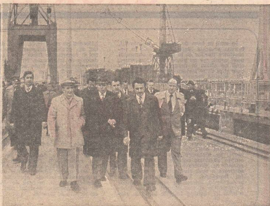
La Șantierul naval din Mangalia
