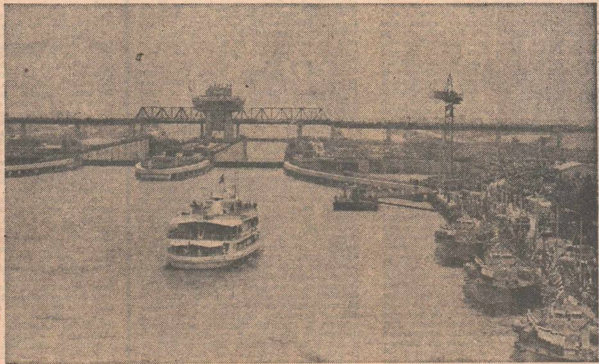
Imagine generală a tronsonului ecluzei de la Agigea
