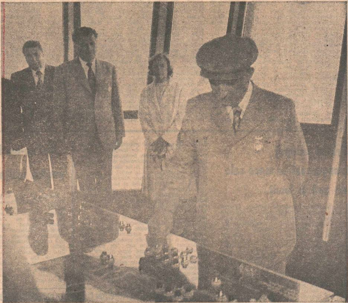
Printre-o apăsare de buton tovarășul Nicolae Ceaușescu dă comanda pentru efectuarea operațiilor tehnice de ieșire a primului convoi de șlepuri în mare, prin ecluza de la Agigea
