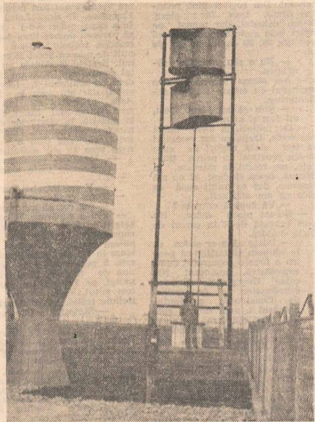
Pomparea apei se realizează la ferma Vișina a I.A.S. Corabia cu ajutorul unei instalații eoliene.
