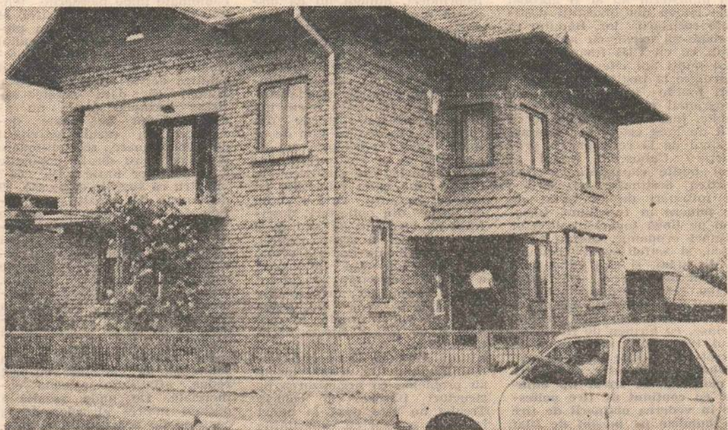
Peisaj cotidian : case-vile, autoturisme, băi, canalizare, asfalt...
