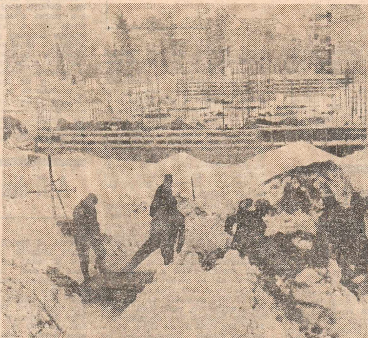
Centrul Tirgoviște se va îmbogăți, curînd, cu o nouă construcție, la care, chiar acum, în plin februarie, se lucrează intens
