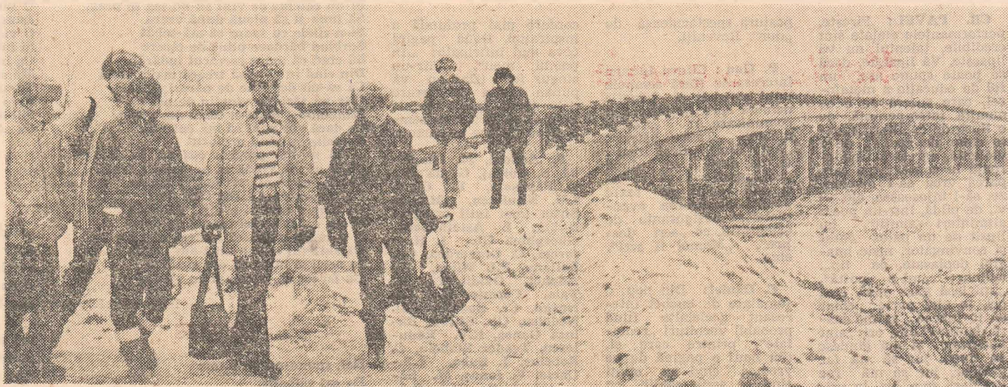
Noul pasaj o legătură rapidă cu centrul
