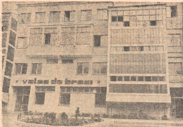
Nu este un motel, cum oricine ar fi tentat să creadă, ci sediul minei „Valea de Brazi” (construit de brigada 4 a I.A.M.M.C.).
