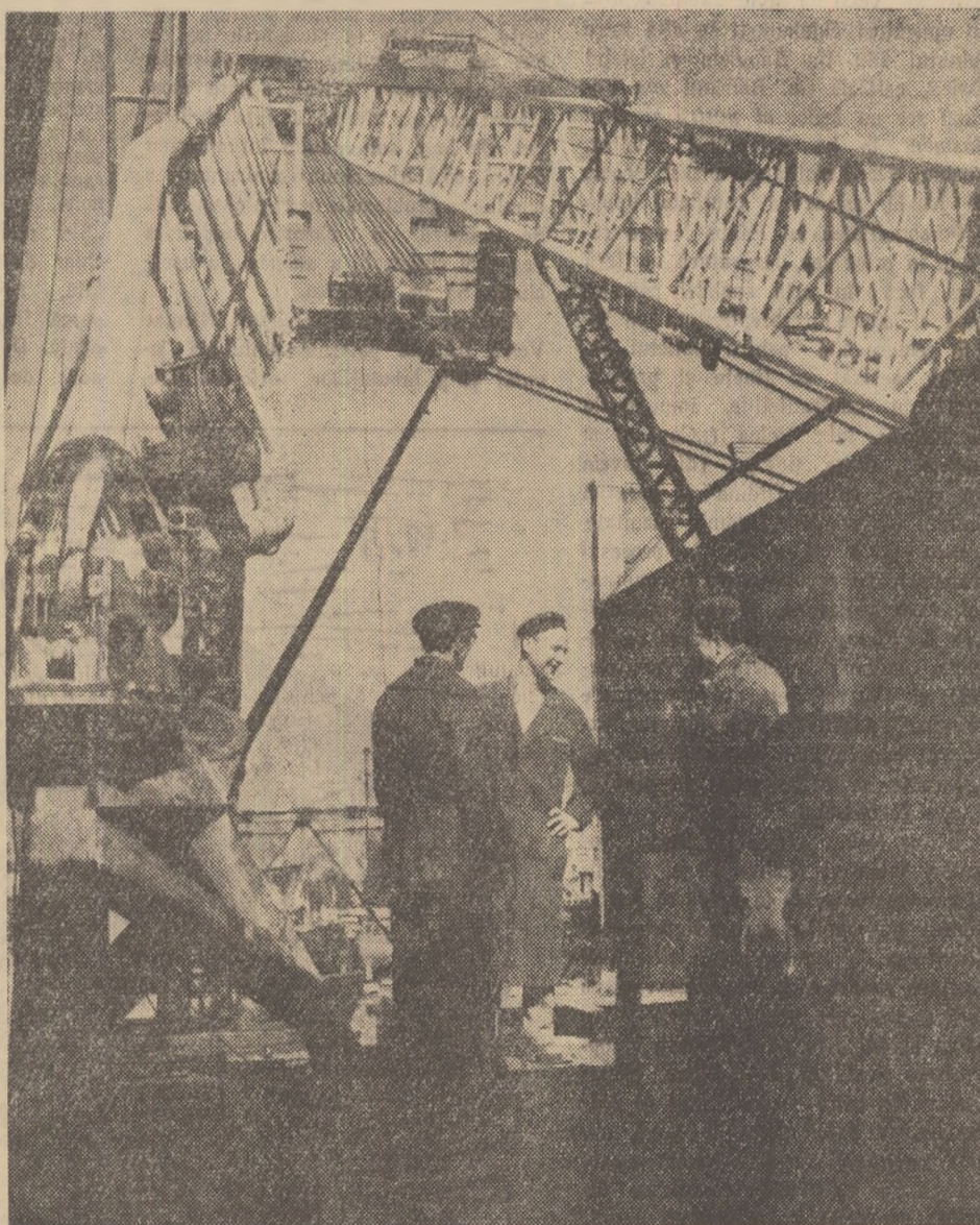
Probleme fizice ale ridicării turlei, la instalația modernă de foraj „A.L.D.”
