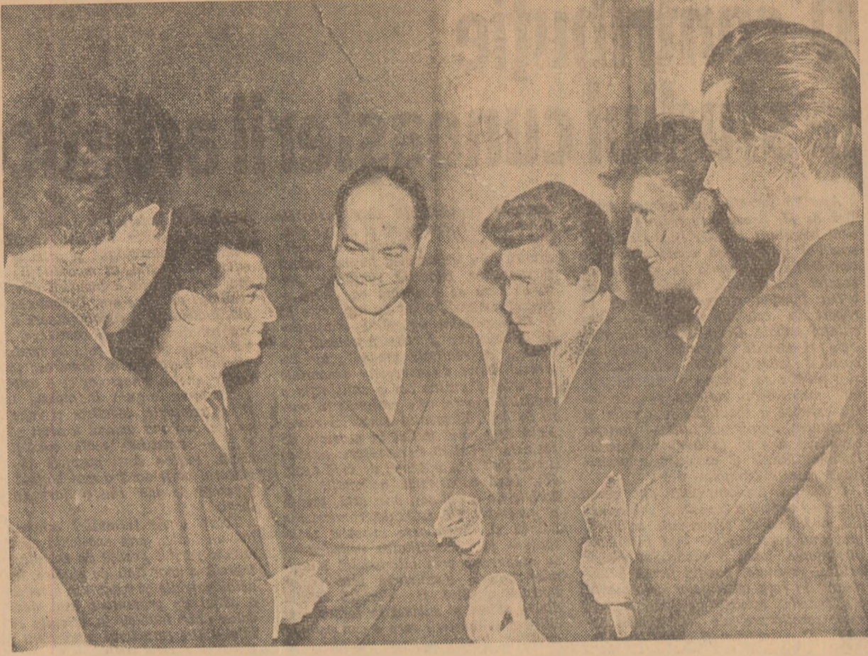
În timpul unei pauze a lucrărilor.
