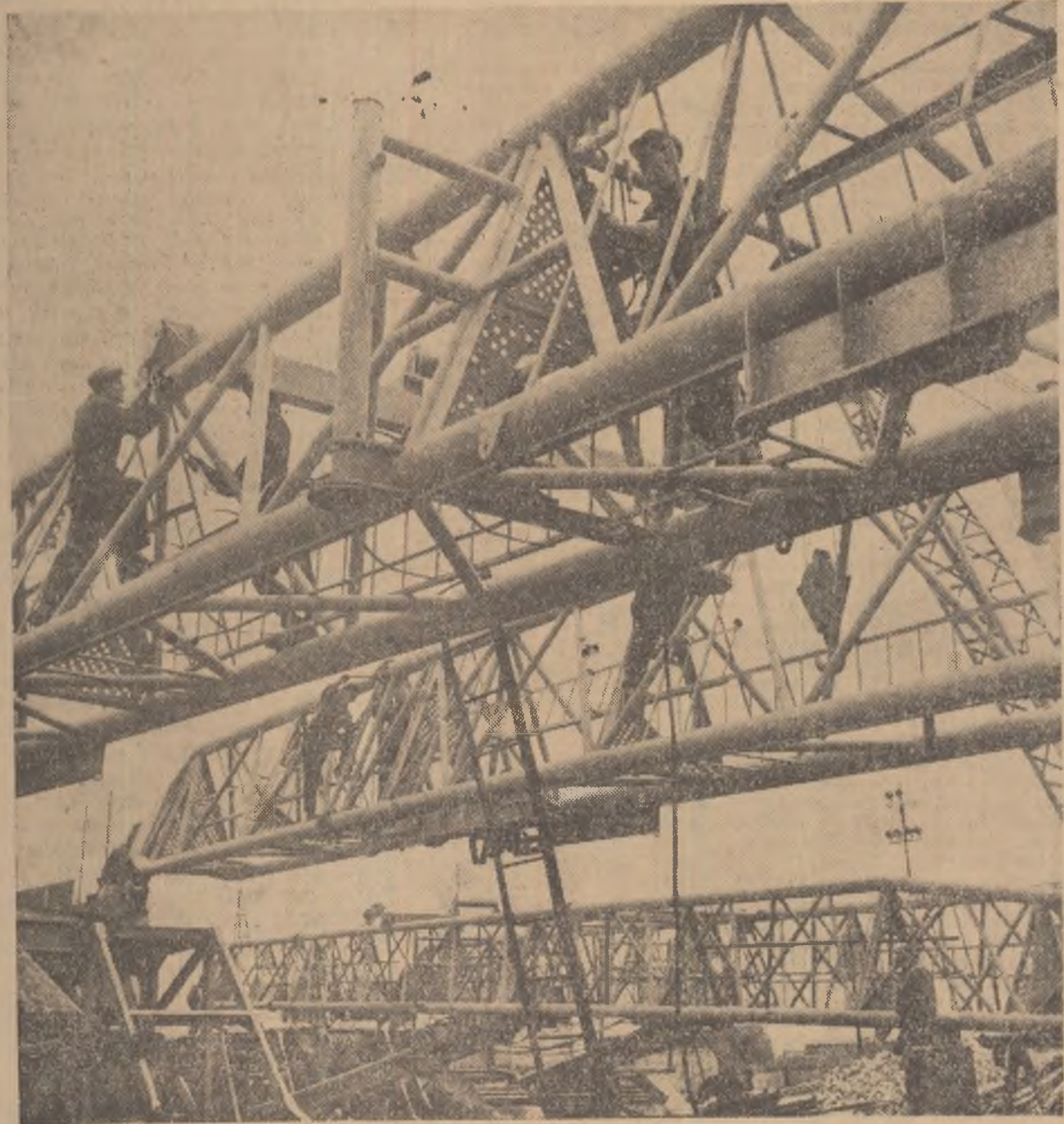
La Uzinele „1 Mai” din Ploiești, pe platoul de montare a instalațiilor de foraj 4 L.D.
