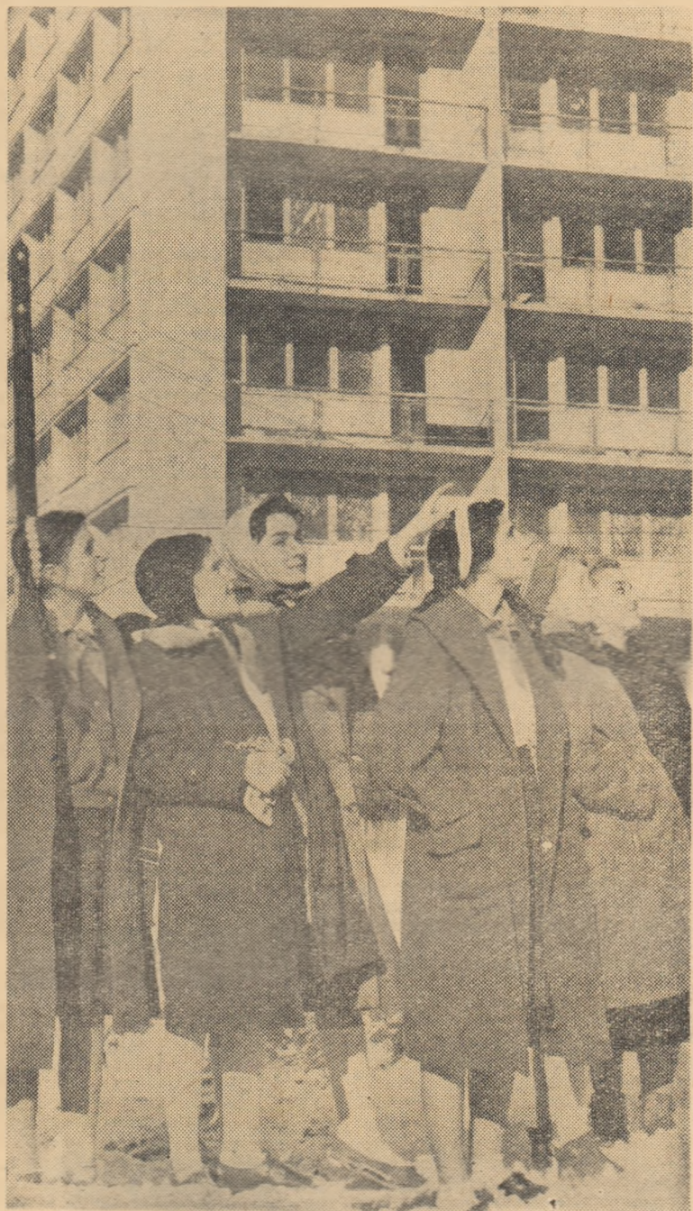
Elevii școlilor din cartier admiră cu mîndrie noile clădiri de pe marele șantier de locuințe ce se înalță pe magistrala nord-sud din Capitală.
