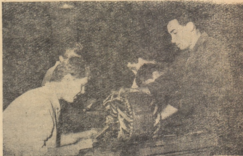
Ucenic al Școlii profesionale „Klement Gottwald” din Capitală bobinînd un electro-motor.
