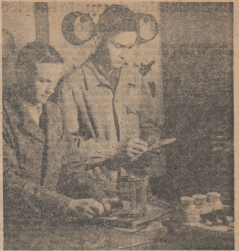
Lucrări practice de electrificarea
