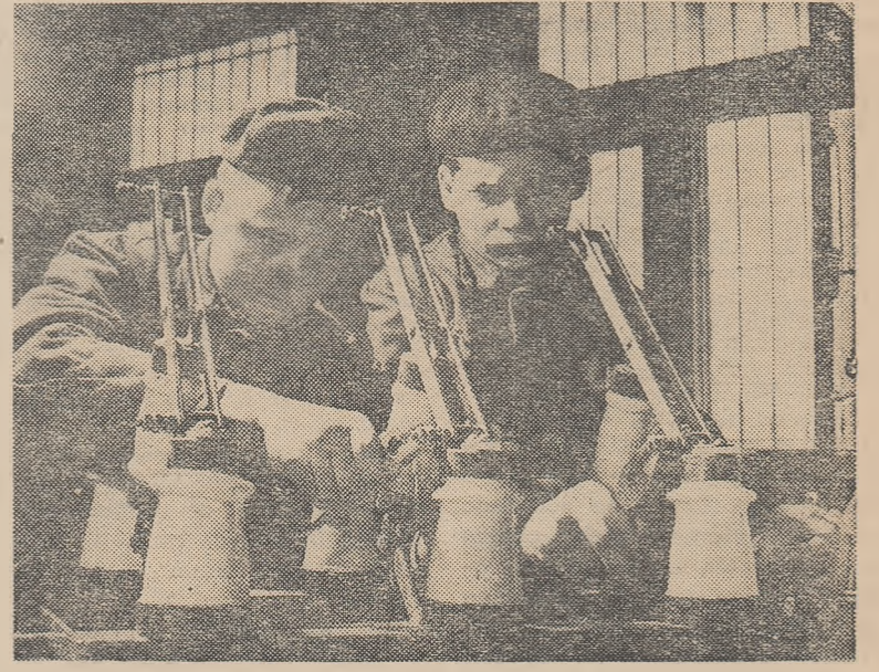
Montarea unui separator triazic în cadrul construcției de specialitate în atelierul-școală al Centrului școlar de construcții din București
