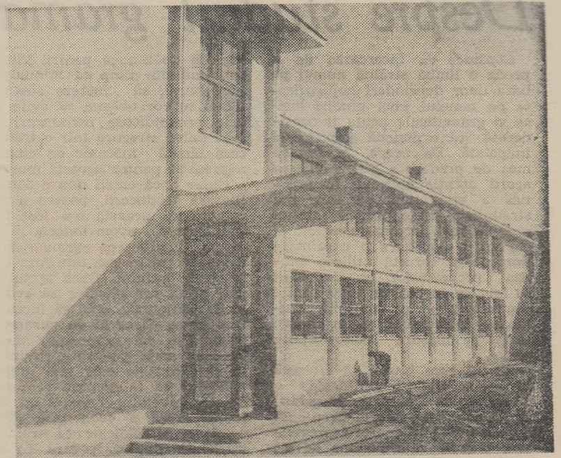
Noul local al Școlii tehnice sanitare din Tg. Mureș
