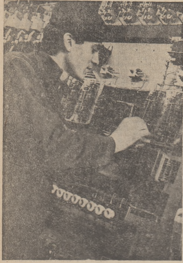
Instalarea și controlul rețelelor și stațiilor electrice constituie o muncă pasionantă și de înaltă tehnicitate
