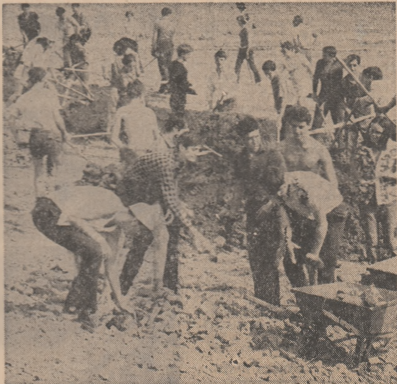
Zile de lucru pe șantierele reconstrucției din județul Tg. Mureș
