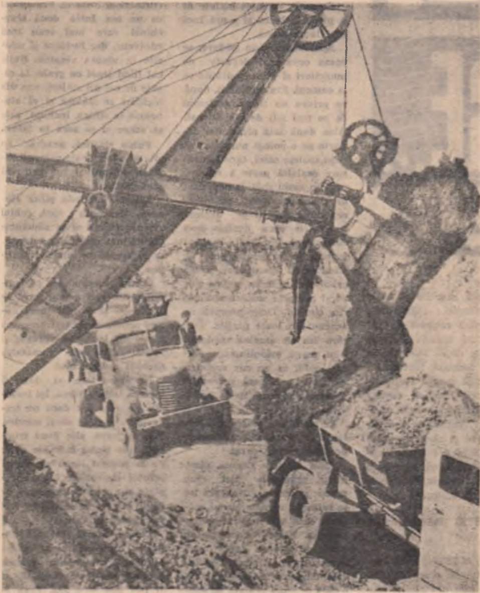
Autobasculante la escavatorul lui Nicolae Aștef.
