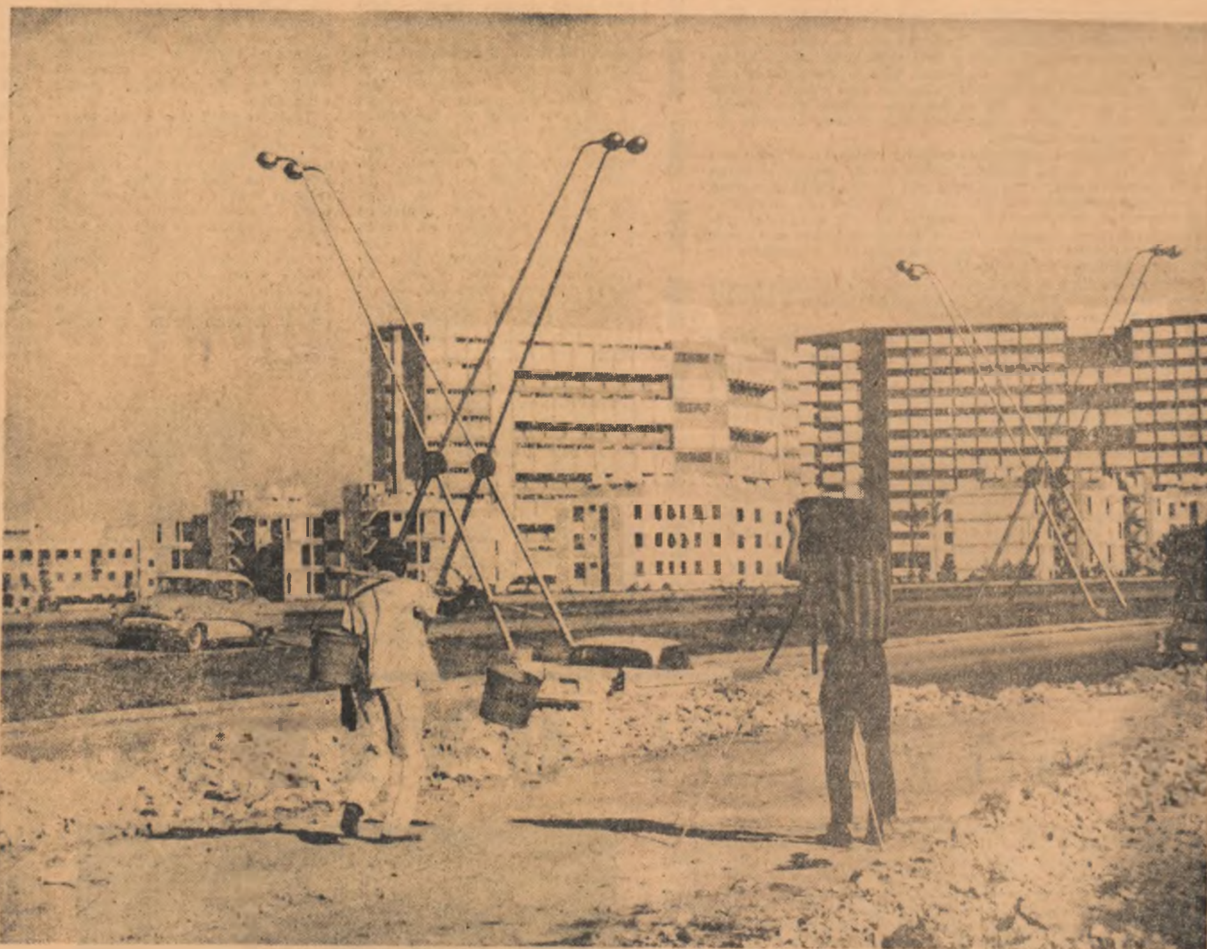
Noi blocuri de locuințe la Havana
