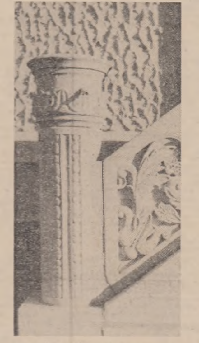
Detaliu de arhitectură brâncovenească
