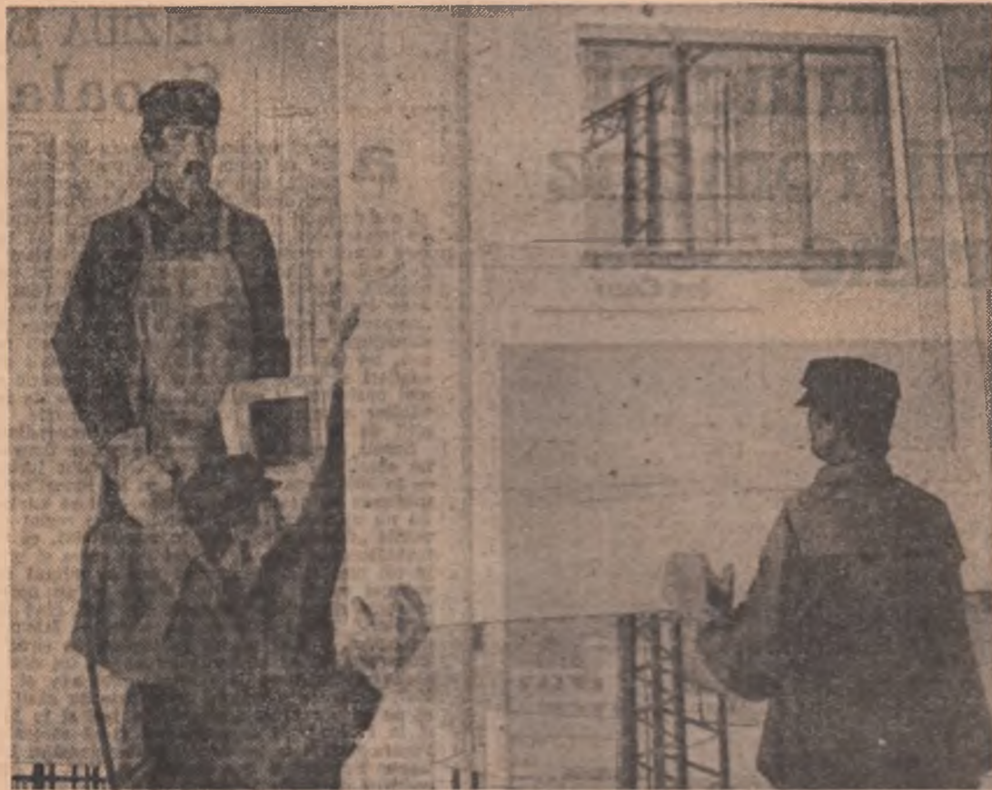
Spiru Chintilă: „Constructivi”
