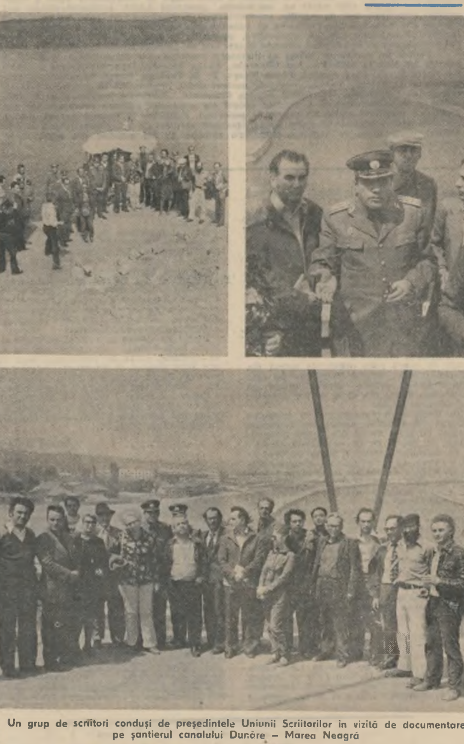
Un grup de scriitori conduși de președintele Uniunii Scriitorilor în vizită de documentare pe șantierul canalului Dunăre — Marea Neagră
