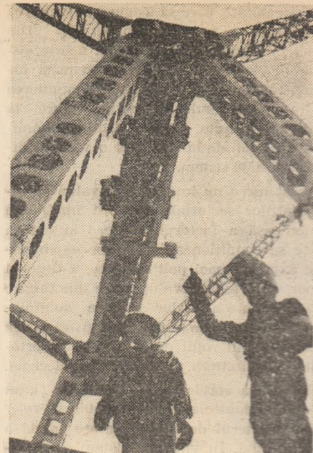
Tara întreagă — un șantier în care se construiește viitorul
