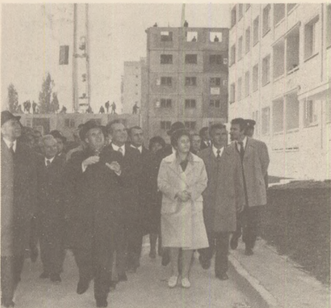
Programul construcției de locuințe – expresie a grijii pentru condițiile de locuit ale oamenilor muncii; în actualul cincinal vor fi date în folosință peste un milion de apartamente din fondurile sau cu sprijinul statului și circa 250 000 de locuințe din fondurile populației
