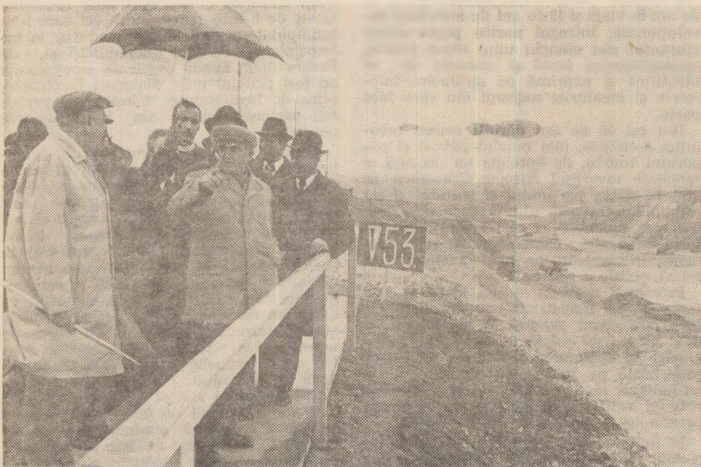
Pe șantierul uneia din marile construcții ale socialismului, secretarul general al partidului analizează, împreună cu specialiști, modalitățile cele mai eficiente de organizare a lucrărilor
