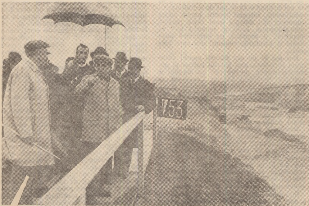
Pe șantierul uneia din marile construcții ale socialismului, secretarul general al partidului analizează, împreună cu specialiști, modalitățile cele mai eficiente de organizare a lucrărilor
