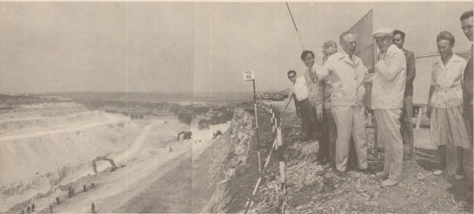
Pe șantierul național al tineretului de la Basarabi
