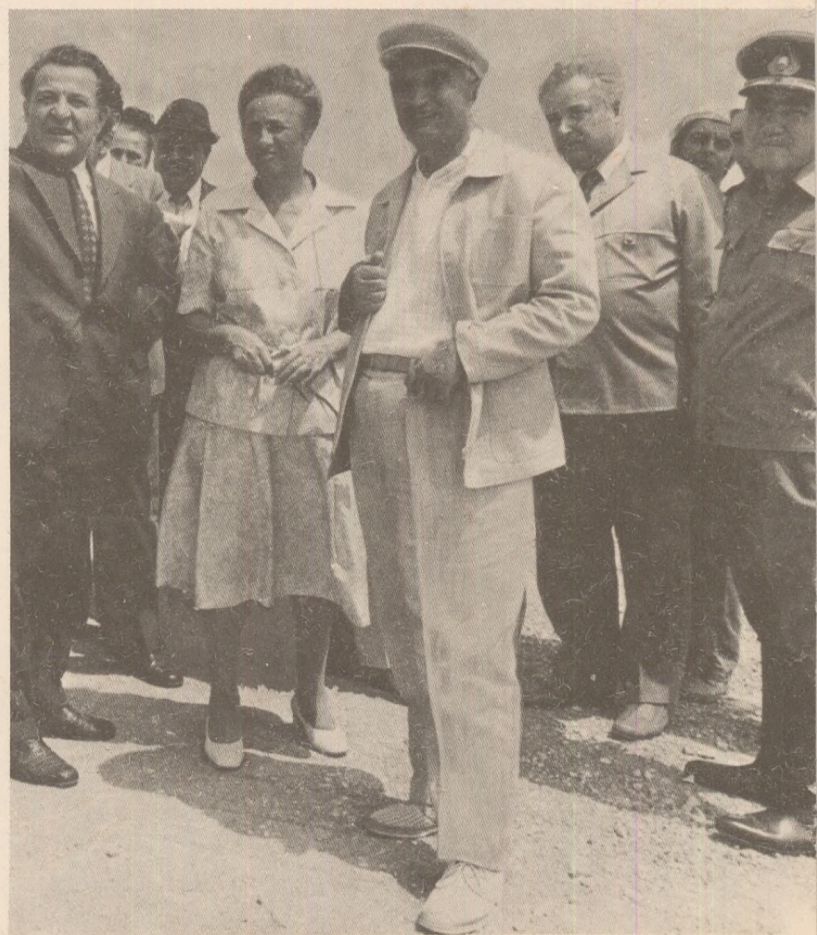
Pe șantierul viitorului port Constanța Sud — Agigea
