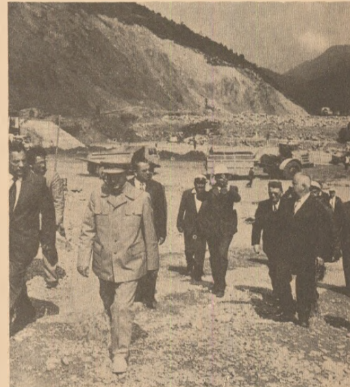
Asigurarea independenței energetice a țării se înfăptuiește prin dezvoltarea resurselor energetice proprii și prin raționalizarea consumurilor
