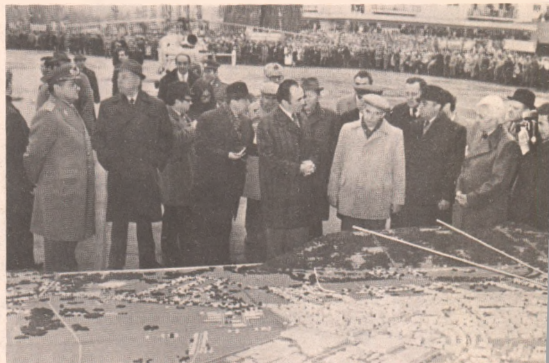
Componentă importantă a amplului program inițiat de tovarășul Nicolae pentru ridicarea nivelului de trai al poporului, construcția de locuințe este în procesul sistematizării localităților patriei
