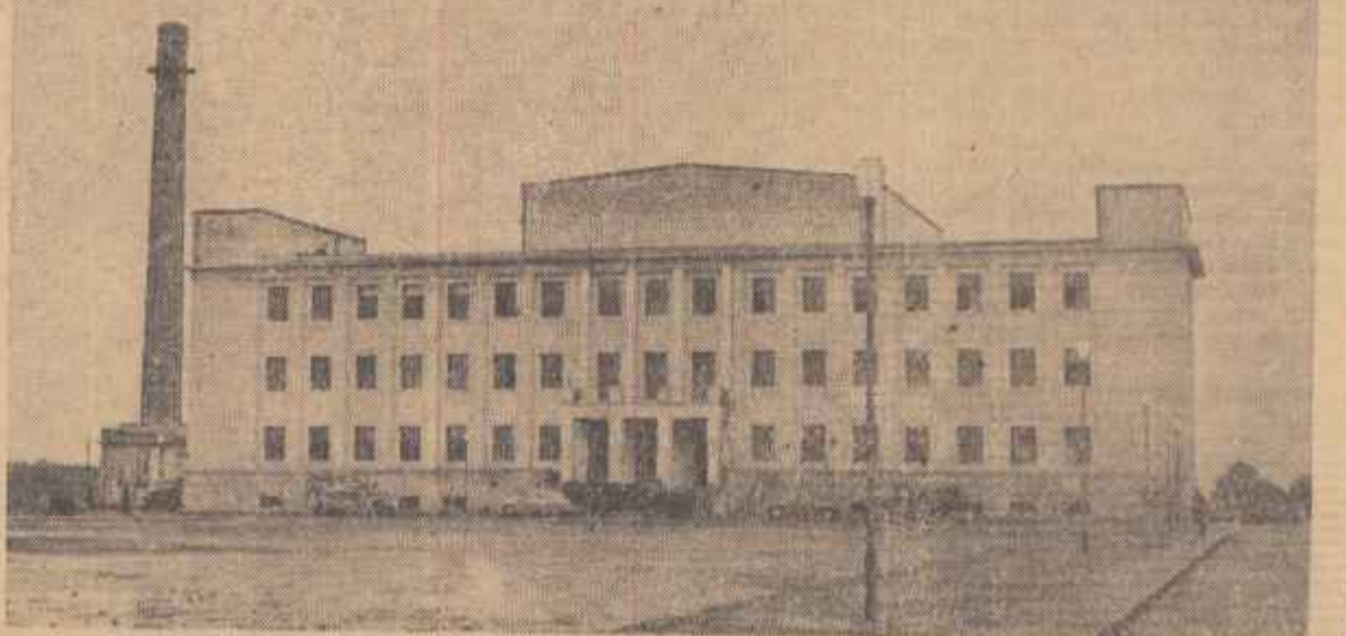
Un aspect al clădirii reactorului nuclear.
