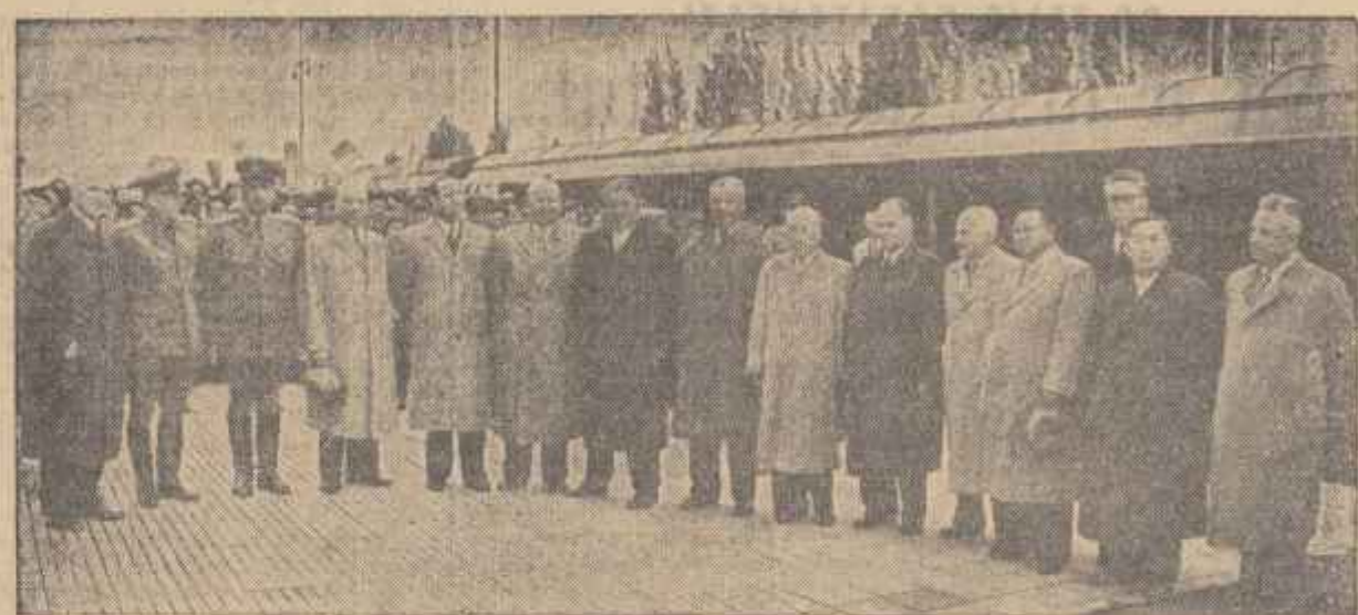
Pe peronul gării Băneasa înainte de plecare.
