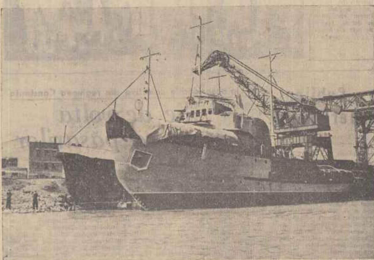
La Șantierul Naval din Galați s-a sărbătorit de curând lansarea la apă, cu 10 zile înainte de termen, a unui remorcher de 1.200 H.P. Datorită sudurii automate și metodei noi de croire a cadel, la construirea remorcherului s-au realizat economii în valoare de 50.000 lei. În cliseu: remorcherul de 1.200 H.P. lansat la apă.
