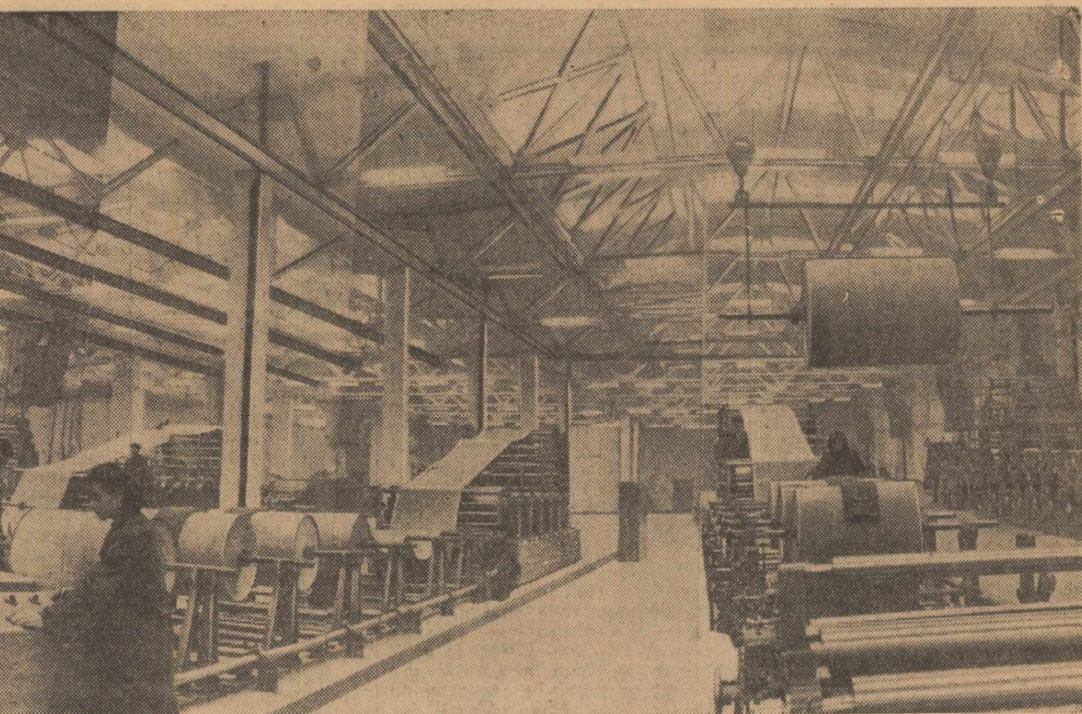
Vedere generală a unei hale de la Fabrica de saci și pungi
