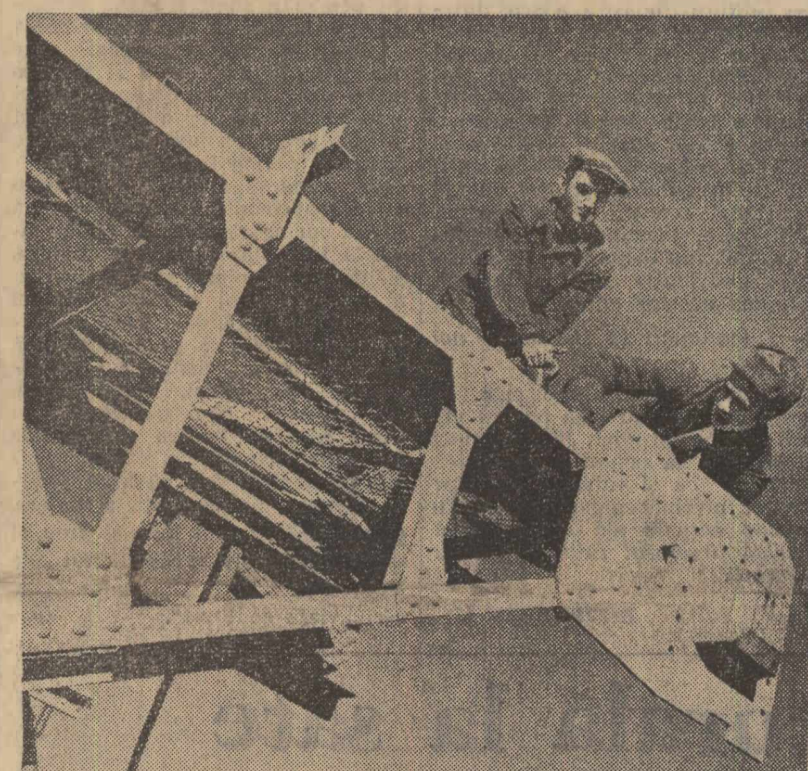
Nituriții Ion Marinescu și Constantin Lazăr de la Întreprinderea de poduri metalice și prefabricate din Pitești, se numără printre fruntașii întreprinderii. Fotografia noastră îl înfățișează în momentul niturii definitive a unui pod rulant de 20,5 m.
