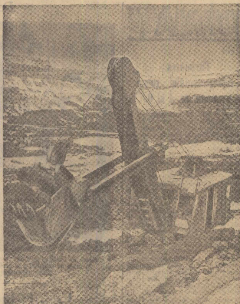
Exploatarea minieră de la Rovinari. Excavatorul condus de Ion Cîncu este în plin lucru. Cupele pline viri cu cărbune, sînt desăvîrșite pe banda transportoare.
