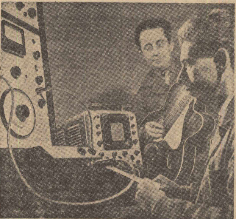
În laboratorul de electroacustică al fabricii de Instrumente muzicale „Dolna“ ing. Șerban Platon și chimistul Dan Mănescu studiază posibilitatea de înlocuire la chitară a corzilor de oțel cu corzi din material plastic.
