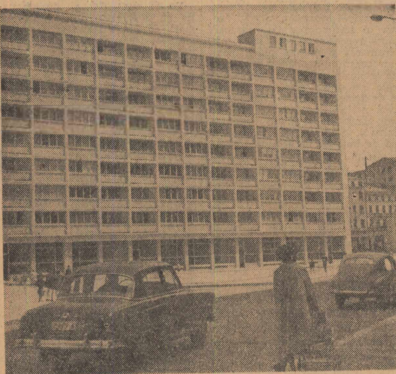
Ansamblul de locuințe din Piața Palatului R.P.R. s-a îmbogățit recent cu un bloc nou amplasat pe str. 13 Decembrie nr. 6. În clădire: Aspect exterior al noului bloc
