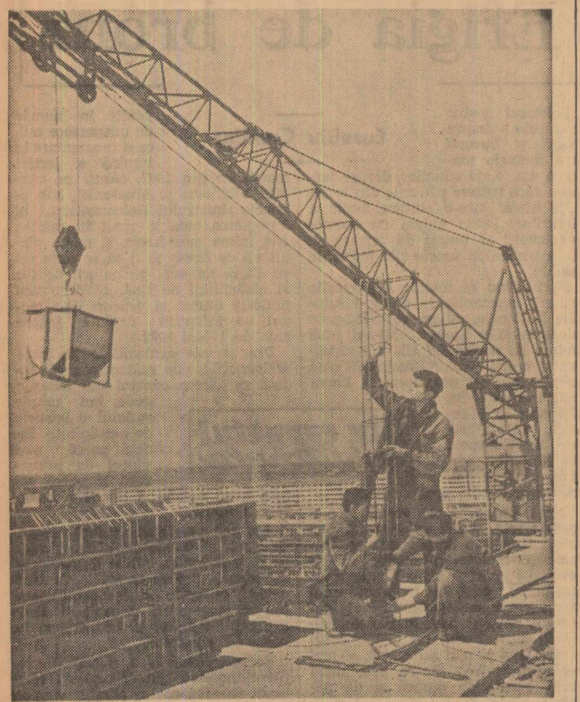
Practica pe marile șantiere constituie pentru studenții Institutului de construcții din Capitală un prilej de a-și consolida noțiunile teoretice predate la cursuri. În clipse: Tînărul fierar-betonist Teodor Zaharia împărțește din experiența sa studenților Radu Stănescu și Dan Lungu de la Facultatea de construcții care fac practică pe șantierul de locuințe din Giulești.
